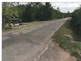
ROZHLED NA SILNICI DOPRAVA
